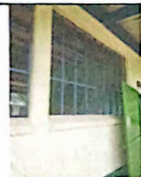
Foto 3: Mantenimiento de balcón de metal y pintura para balcón.
