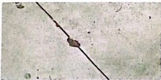
Foto 5: Sustrucción de piso líquido a cerámico.
