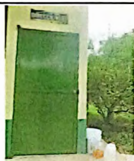
Foto 5: Fabricación e instalación de puerta de metal
