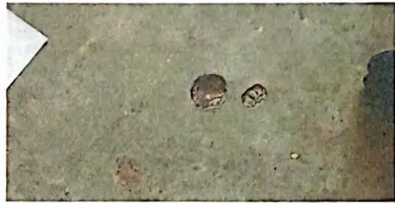
Foto 4: Sustrucción de piso líquido a cerámico.
