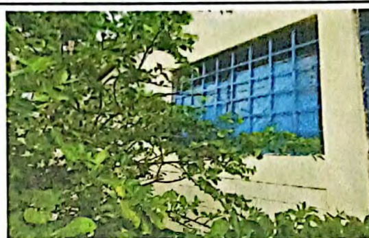
Foto 4: Sustrucción de ventana de metal por vidrio
