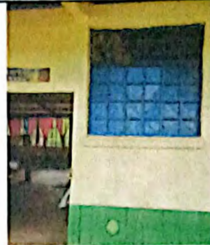
Foto 2: Sustrucción de ventana de metal por vidrio
