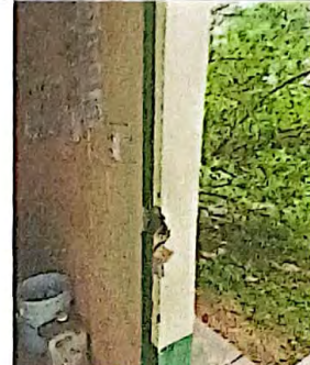
Foto 4: Reparación de muros de contención.
