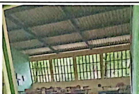
Foto 4: Mantenimiento de balcón de metal y pintura para balcón.
