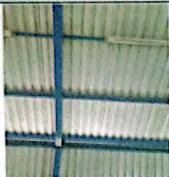
Foto 1: Sustrucción de lámina, por lámina troquelada Aluzinc calibre 26
