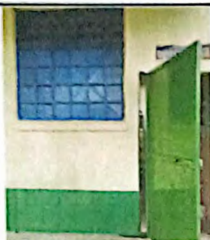
Foto 3: Sustrucción de ventana de metal por vidrio
