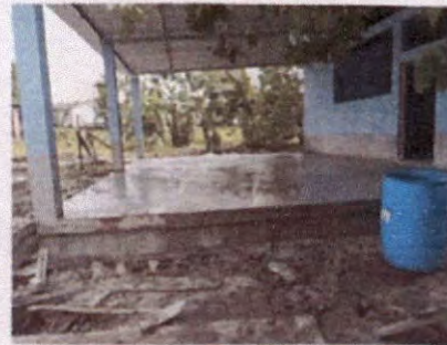
Foto 16. Reparación de piso de torta de concreto
