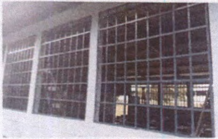
Foto 3: Mantenimiento a estructura de balcones
