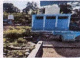
Foto 14. Sustitución de deposito de agua
