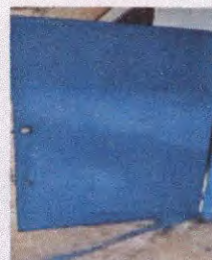
Foto 6. Mantenimiento a estructuras de puertas
