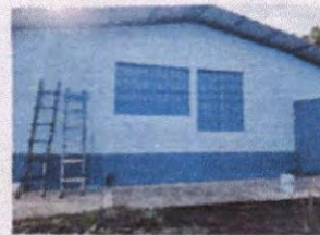
Foto 4: Pintura en muros interiores y exteriores
