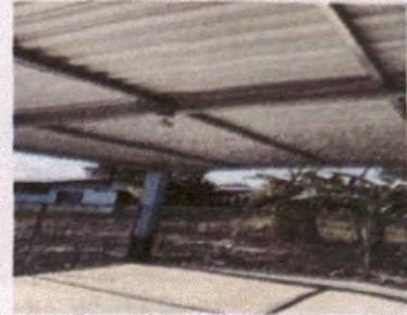
Foto 2: Sustrucción de lamina troquelada aluzunic calibre 26
