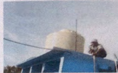
Foto 14. Sustitución de deposito de agua
