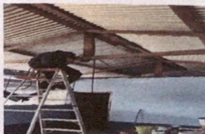
Foto 6: reparacion de cableado electrico
