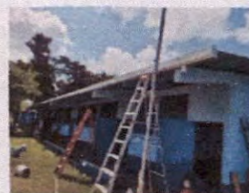
Foto 10: -Sustitución de canal de metal
