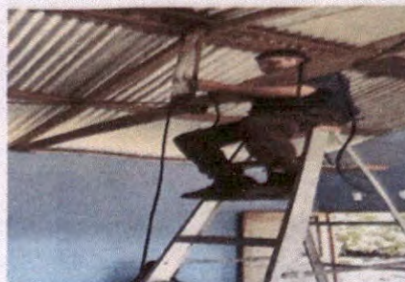
Foto 8: Sustitución de plafoneras
