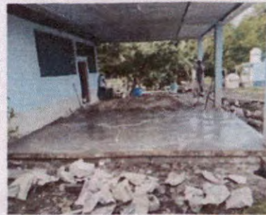
Foto 16. Reparación de piso de Torta de concreto
