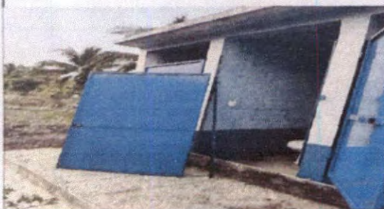
Foto 11: Sustitución de puerta de metal
