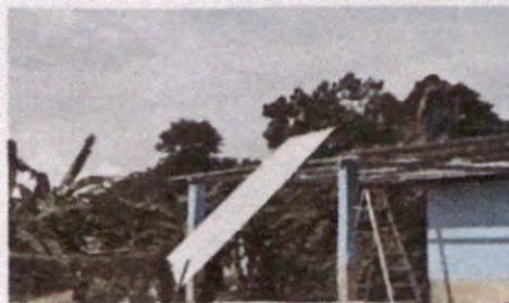
Foto 2: Sustrucion de lámina troquelada de aluzinco calibre 26
