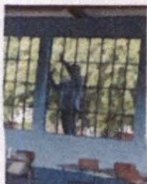
Foto 3: Mantenimiento de estructura de balcones de metal
