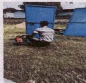
Foto 12: Mantenimiento a estructura de puertas
