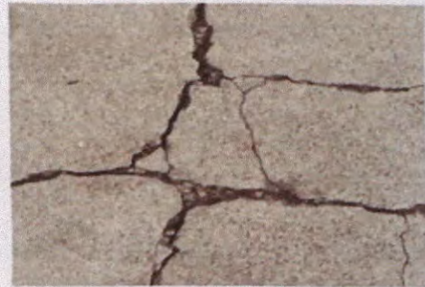
Foto 16. Sustitución de piso de concreto
