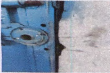
Foto 13. Sustitución de chapas
