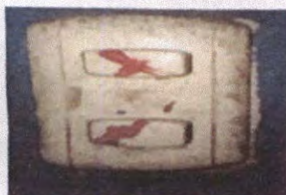
Foto 9: Sustrucion de interruptor doble
