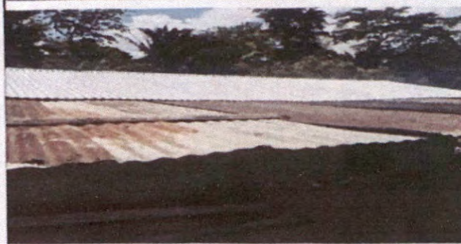
Foto 2: Sustrucción de lámina por láminas troquelada de aluzinc calibre 26
