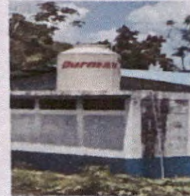
Foto 14. sustitución de deposito de agua
