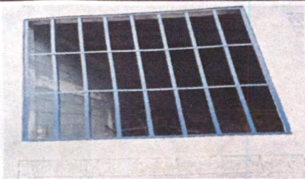
Foto 3: Mantenimiento de estructura de balcones de metal
