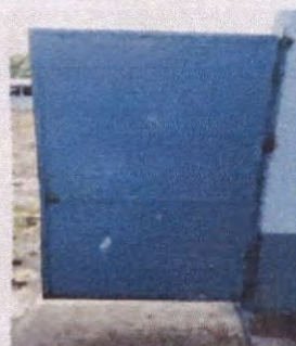
Foto 12: Mantenimiento de estructuras de puertas
