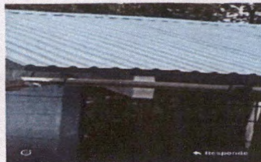
Foto 10: Sustrución de canal de metal
