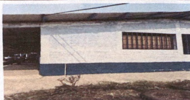
Foto 4: Pintura en muros interiores y exteriores
