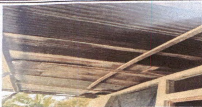
Foto 1: Sustrucción de estructura de soporte de madera por metal
