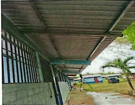
SUSTITUCIÓN DE LAMINA POR LAMINA TROQUELADA ALUZINC CALIBRE 26
