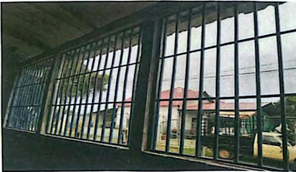
MANTENIMIENTO A BALCON DE METAL
