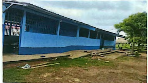
PINTURA EN MURO EXTERIOR E INTERIOR
