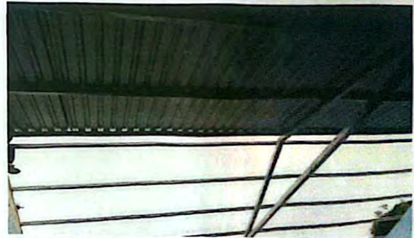
SUSTITUCION DE SOPORTE DE MADERA, POR METAL
