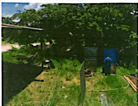
SUSTITUCIÓN DE PUERTA
