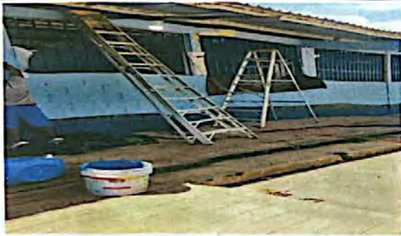
MANTENIMIENTO A BALCON DE METAL
