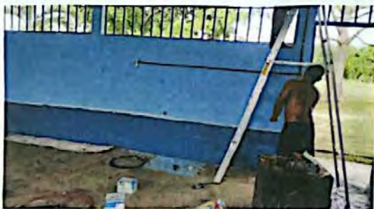
REPARACIÓN DEL CABLEADO ELECTRICO
