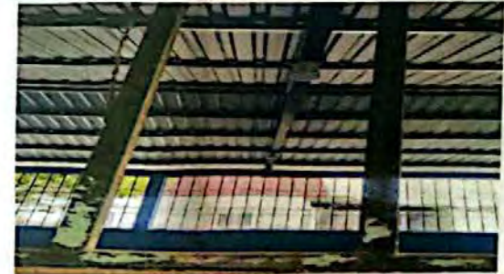
SUSTITUCIÓN DE PLAFONERAS
