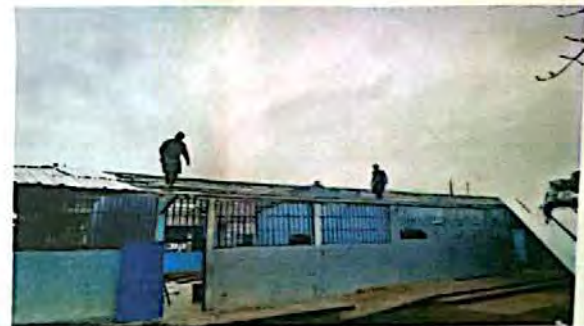
SUSTITUCION DE SOPORTE DE MADERA, POR METAL
