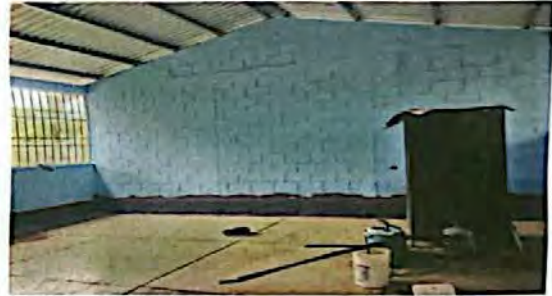
PINTURA EN MURO EXTERIOR E INTERIOR
