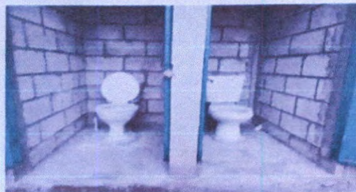
Renglón 5 Sustitución de inodoro
