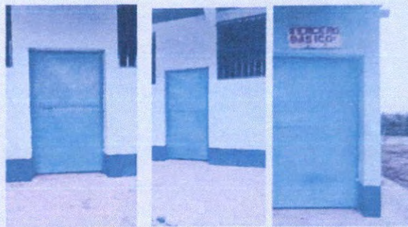
Renglón 2 Sustitución de puertas de metal
