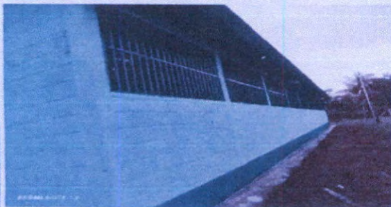
Renglón 7 pinturas en muros exteriores
