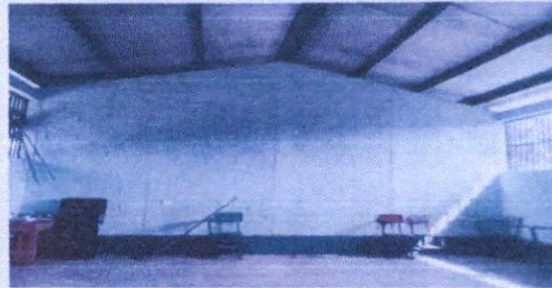
Renglón 7 Pintura en muros interiores
