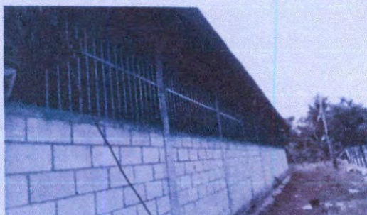
Renglón 3 Mantenimiento a balcones de metal
