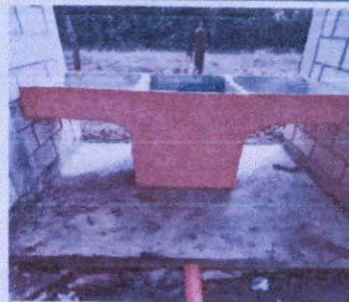
Renglón 6 Sustitución de pila de cemento de 2 lavaderos
