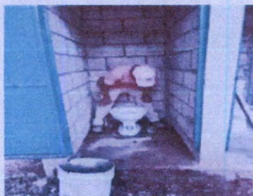
Renglón 5 Sustitución de inodoro
