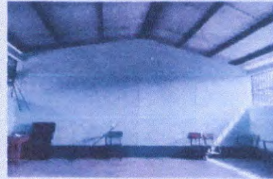
Renglón 7 pintura en muros exteriores e interiores
