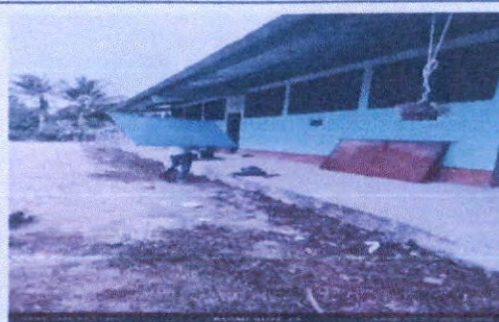
Renglón 2 Sustitución de puertas de metal
