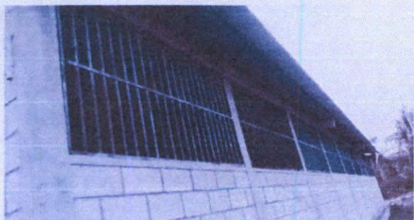
Renglón 3 Mantenimiento a balcones de metal
