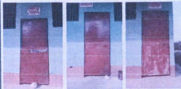
Renglón 2 Sustitución de puertas de metal
