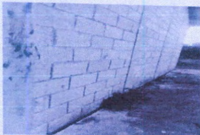
Renglon 7 Pintura en muros exteriores e interiores
