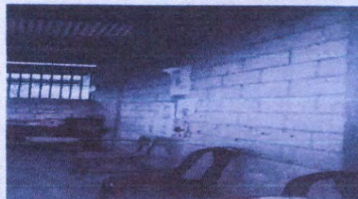
Renglon 7 Pintura en muros exteriores e interiores
