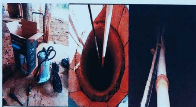
Foto 5: RENGLO 18 SUSTITUCION DE BOMBA DE AGUA
