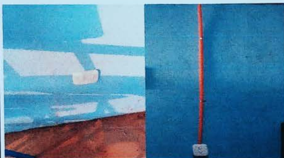
Foto 3: RENGLO 17.7 SUSTITUCION DE INTERRUPTORES DOBLES
