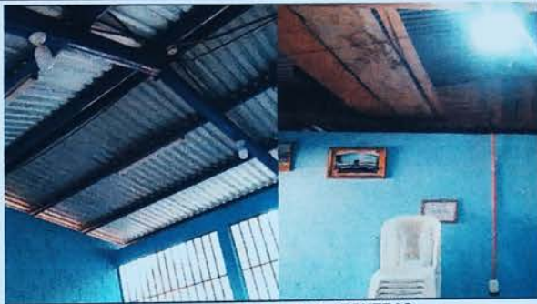
Foto 2: RENGLO 17.5 SUSTITUCION DE PLAFONERAS
