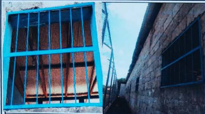
Foto1: RENGLO 5 SUSTITUCION DE BALCONES DE METAL
