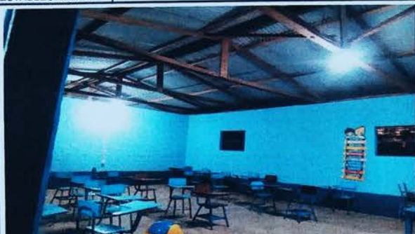
Foto1: RENGLO 17.4 SUSTITUCION DE FOCOS AHORRADORES
