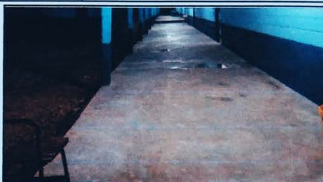
Foto 2: RENGLO 6 REPARACION DE PISO DE TORTA DE CONCRETO
