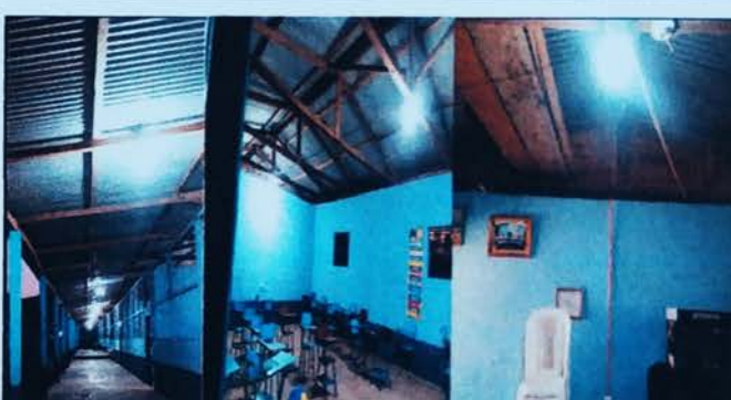
Foto 4: RENGLO 17 REPARACION DE CABLEADO ELECTRICO
