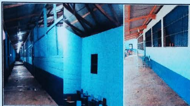
Foto 3: RENGLO 9 PINTURA EN MUROS EXTERIORES E INTERIORES
