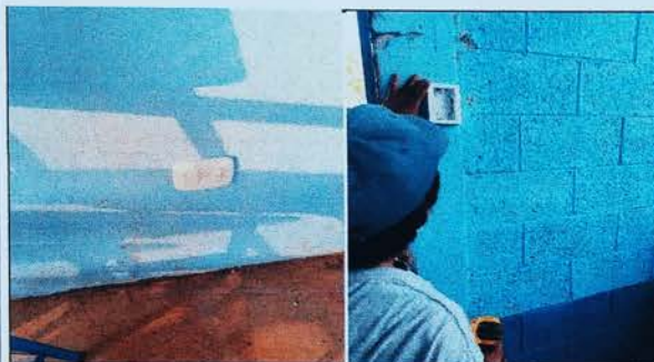
Foto 3: RENGLO 17.7 SUSTITUCION DE INTERRUPTORES DOBLES
