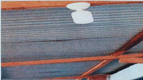
Foto 1: RENGLO 17.4 SUSTITUCION DE FOCOS AHORRADORES
