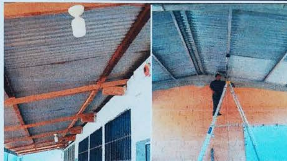
Foto 2: RENGLO 17.5 SUSTITUCION DE PLAFONERAS
