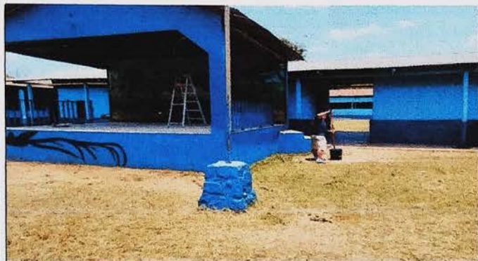
Foto 3: RENGLO 9 PINTURA EN MUROS EXTERIORES E INTERIORES
