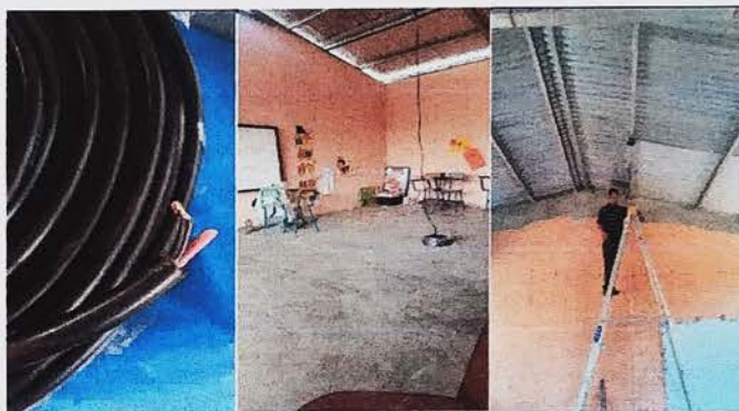
Foto 4: RENGLO 17 REPARACION DE CABLEADO ELECTRICO
