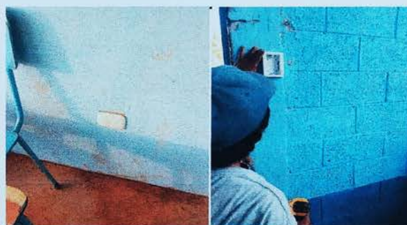
Foto 4: RENGLO 17.8 SUSTITUCION DE TOMACORRIENTES DOBLES
