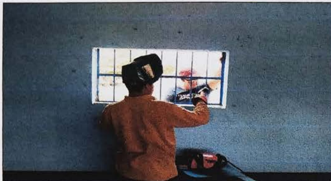
Foto1: RENGLO 5 SUSTITUCION DE BALCONES DE METAL
