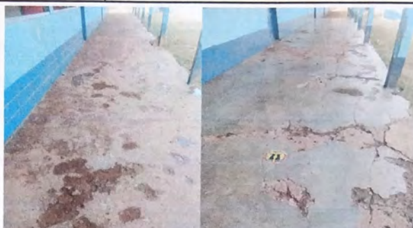
Foto 2: RENGLO 6 REPARACION DE PISO DE TORTA DE CONCRETO
