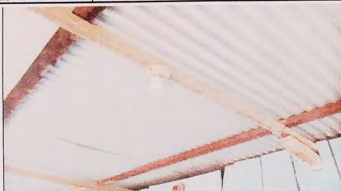
Foto1: RENGLO 17.4 SUSTITUCION DE FOCOS AHORRADORES
