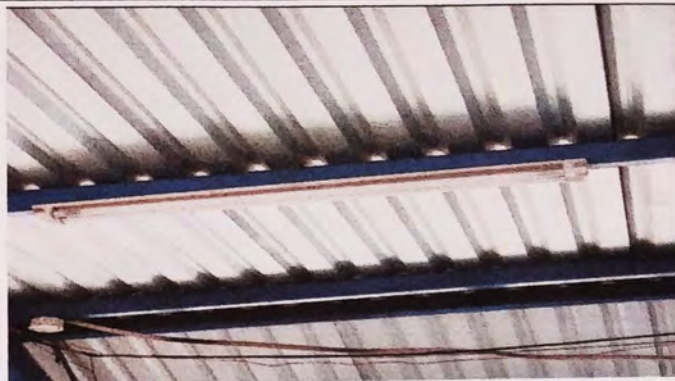
Foto 2: RENGLO 17.5 SUSTITUCION DE PLAFONERAS
