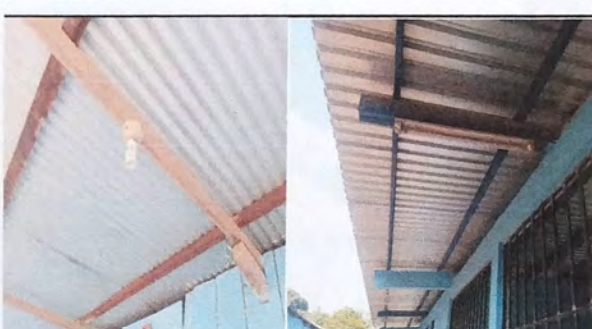
Foto 4: RENGLO 17 REPARACION DE CABLEADO ELECTRICO
