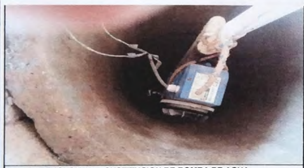
Foto 5: RENGLO 18 SUSTITUCION DE BOMBA DE AGUA
