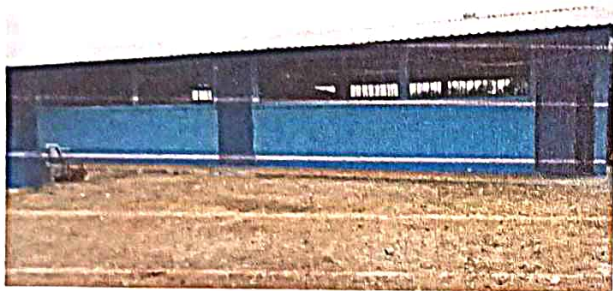
Foto 3: Mantenimiento de soporte de estructura de metal
