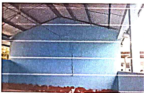
Foto 5: Pintura de muro de interior
