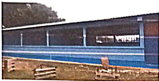
Foto 1: Sustitución de lámina por lámina troquelada
