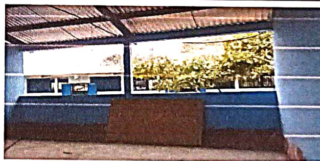
Foto 6: Pintura de muro de interior
