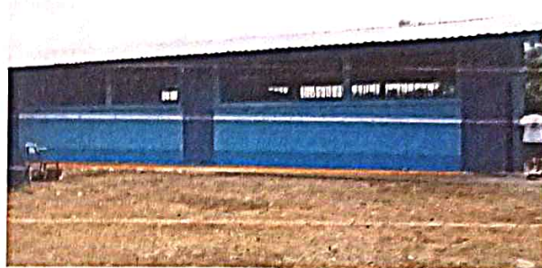
Foto 2: Sustitución de lámina por lámina troquelada
