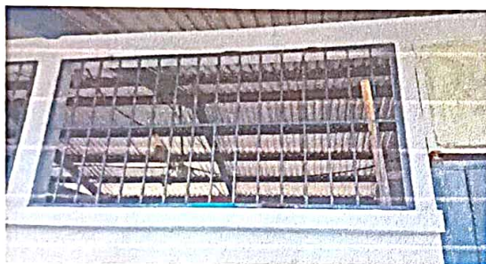
Sustitución de vidrios de ventana
