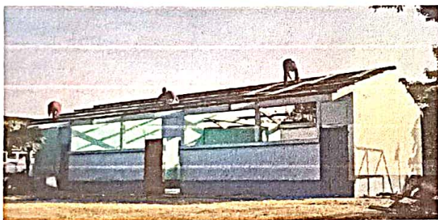
Mantenimiento de soporte de estructura de metal.
