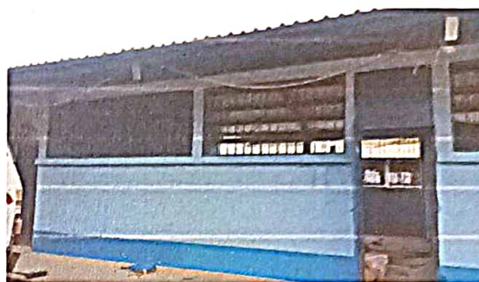
Mantenimiento a estructuras de puertas
