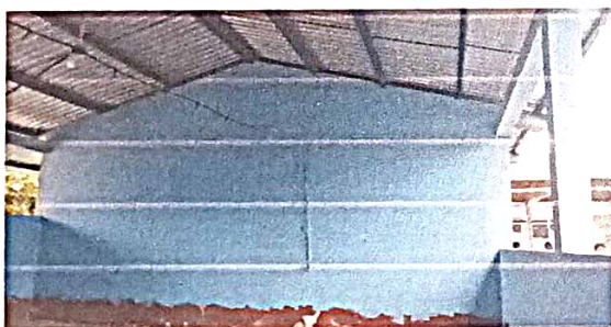
Pintura de muro interior
