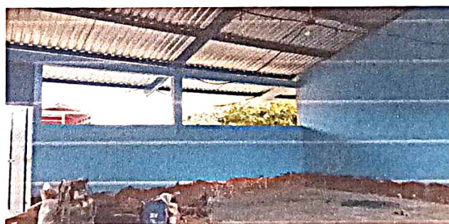
Pintura de muro interior
