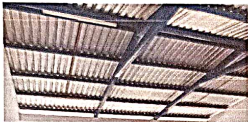
Sustitución de estructura metálica de techo
