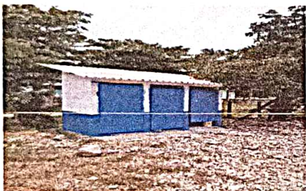
sustitución de puerta de baños
