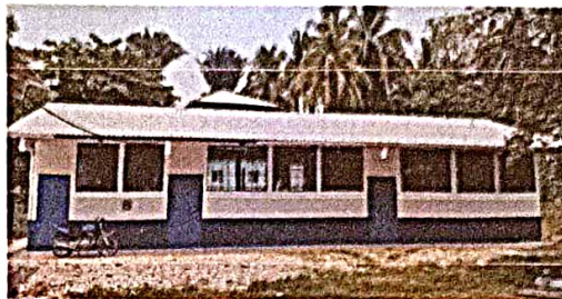
Sustitución de Láminas
