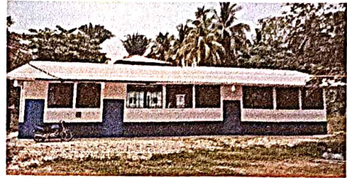
pintura de muros perimetrales exteriores e interiores
