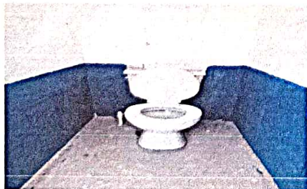
sustitución de tazas de baño
