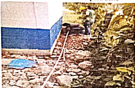
Sustitución de tubería PVC para baño
