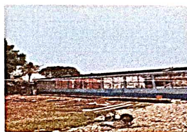
Sustitución de Láminas
