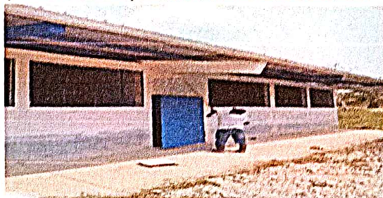
pintura de muros perimetrales exteriores e interiores
