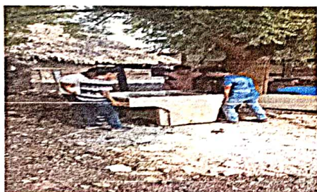
Sustitución de una pila de lavar
