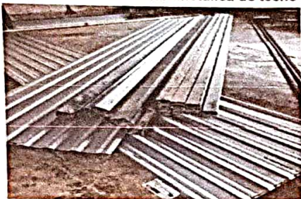
Sustitución de estructurametálica de techo
