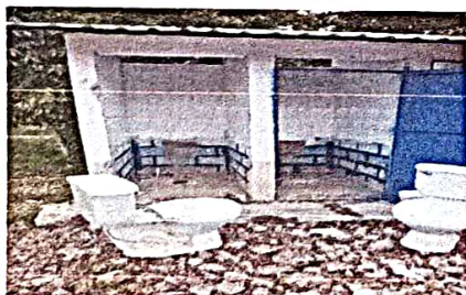
sustitución de tazas de baño
