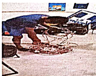
Sustitución de cables de energía eléctrica
