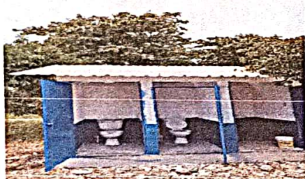
sustitución de puerta de baños
