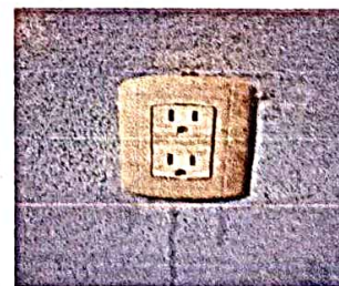
sustitución de tomacorriente
