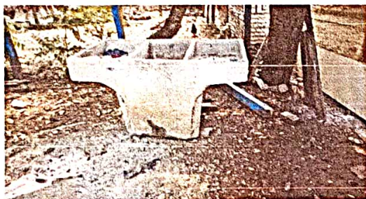
Sustitución de una pila de lavar
