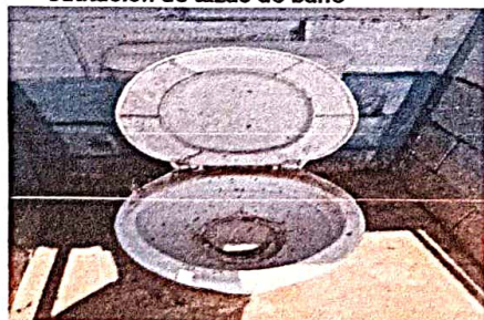
sustitución de tazas de baño
