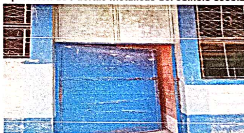
Reparación de Puertas metálicas del edificio escolar
