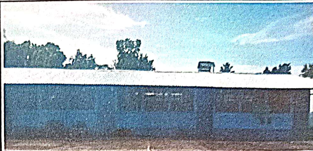
Foto 2: susticion de lamina por lamina troquelada aluzinc calibre 26
