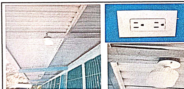
Foto 5: sustitucion de ducto electrico mas accesorios
