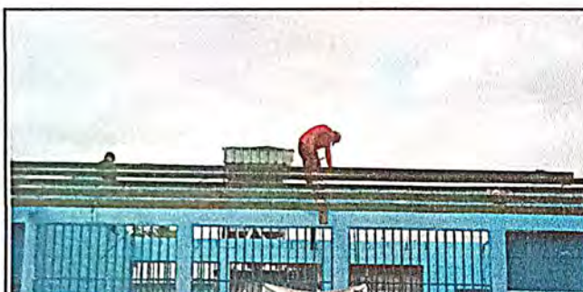
Foto 3: Desinstalacion de soporte metal por metal
