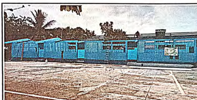
Foto 4: Desinstalación de soporte metal por metal
