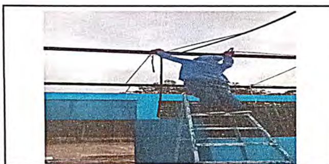
Foto 5: desinstalación de ducto eléctrico mas accesorios
