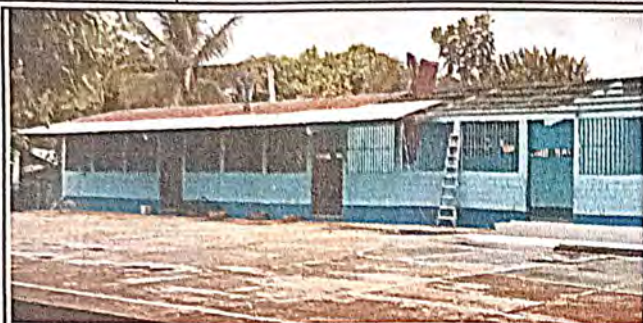
Foto 1: Desinstalacion de lamina
