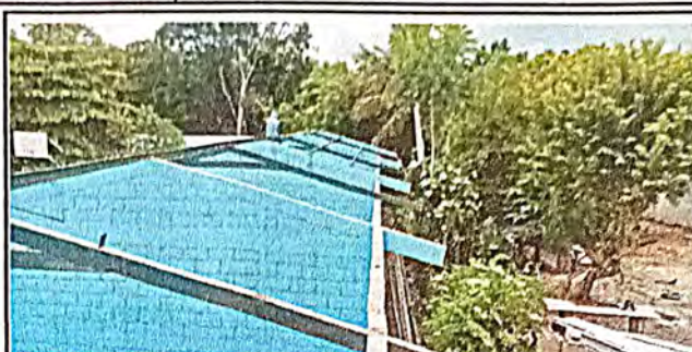
Foto 2: Desinstalacion de lamina
