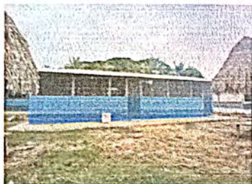
Foto1: Pintura en muros exteriores e interiores
