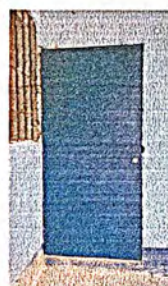
Foto 4: mantenimiento a estructura de puertas de metal
