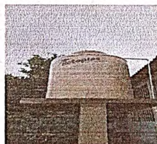
Foto 6: Sustitucion de deposito de agua de 1100 litros
