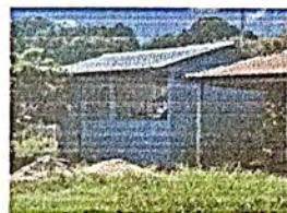
Foto 2: sustitucion de lamina por lamina troquelada de aluzinc calibre 26
