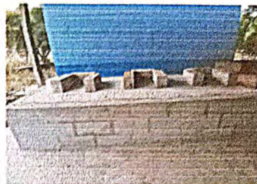
Foto 8: sustitucion de estufa rural
