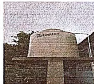
Foto 6: Sustitucion de deposito de agua de 1100 litros
