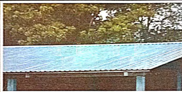
Foto 4: Sustitución de elementos de fijación.
