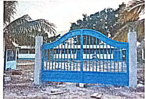
Foto 10: Sustitución de portón de metal.
