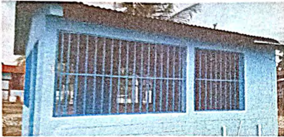
Foto 7: Fabricación e instalación de balcones de metal.
