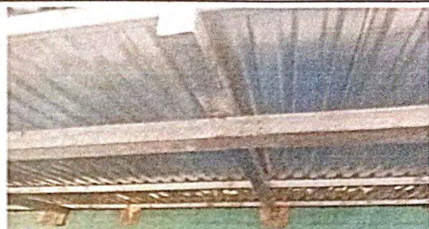
Foto 2: Sustitución de estructura de madera por metal.
