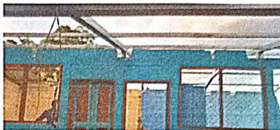
Foto 2: Sustitución de estructura de madera por metal.
