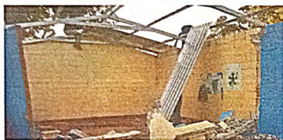
Foto 3: Sustitución de capote de lámina para lámina troquelada.
