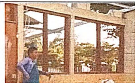
Foto 5: Fabricación e instalación de balcones de metal.
