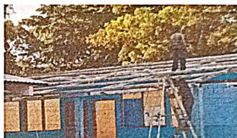
Foto 4: Sustitución de elementos de fijación.
