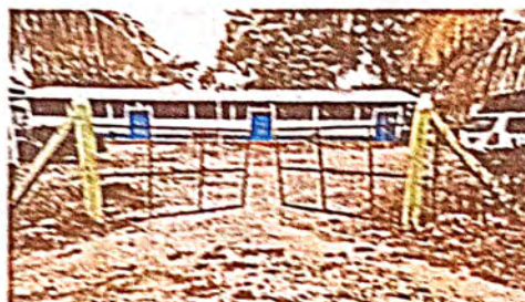
Foto 10: Sustitución de portón de metal.
