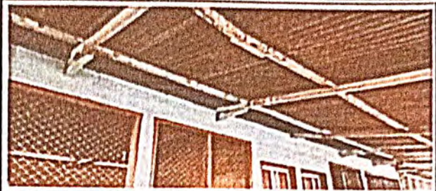
Foto 2: Sustitución de estructura de madera por metal.
