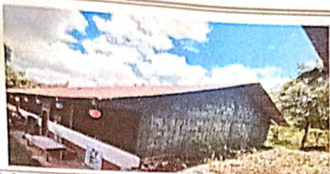
Foto 7: Pintura en muros exteriores e interiores
