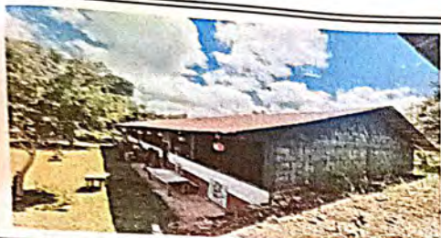
Foto1: Sustrucción de lamina, por lamina troquelada aluzinc calibre 26 modulo de aulas y direccion
