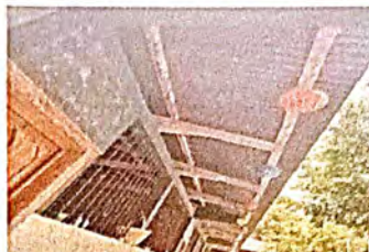
Foto 2: Sustrucción de estructura de soporte de madera, por metal
