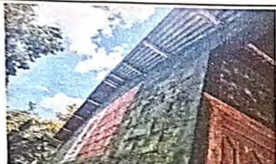
Foto 3: Sustrucción de capote de lamina para lamina troquelada
