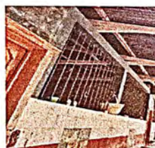
Foto 6: Mantenimiento a balcones de metal
