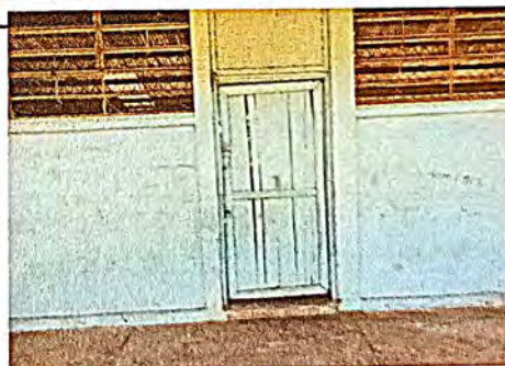
Foto 6: Sustitucion de puerta (aula 2)
