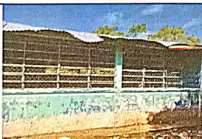
Foto 9: Sustitución de Balcones de metal (aula 1)
