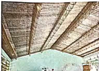
Foto 1: Sustitucion de estructura de soporte de metal por metal (Aula 1)
