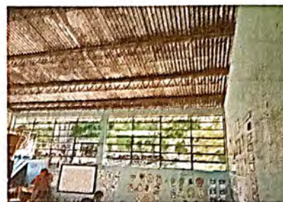
Foto 2: Sustitucion de estructura de soporte de metal por metal (Aula 2)
