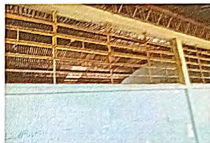
Foto 10: Sustitución de balcones de metal (aula 2)
