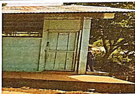
Foto 5: Sustitución de puerta (aula 1)
