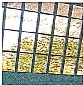
Foto 9: Sustitución de Balcones de metal (aula 1)
