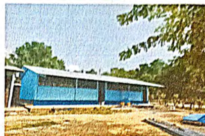
Foto 8: Pintura en muros exteriores e interiores (baños)
