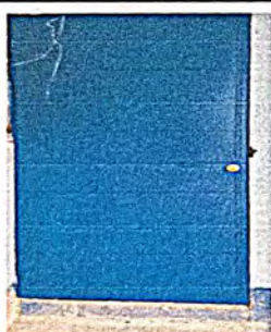
Foto 5: Sustitución de puerta (aula 1)
