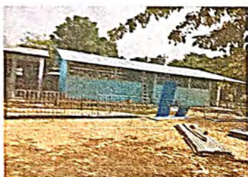
Foto 3: Sustitucion de lamina por lamina troquelada de aluzinc (aula 1)
