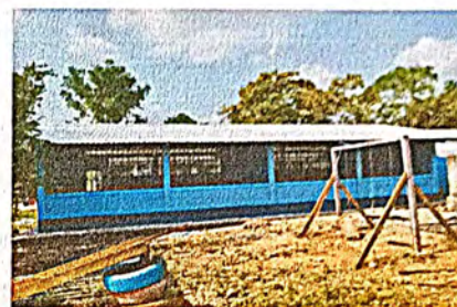
Foto 10: Sustitución de balcones de metal (aula 2)
