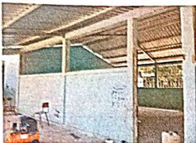
Foto1: Sustitucion de estructura de soporte de metal por metal (Aula 1)
