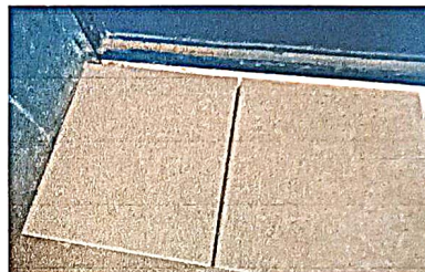
Foto 4: Sustitucion de piso ceramico
