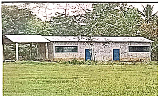
Foto 3: Sustitucion de lamina, por lamina troquelada de aluzinc calibre 26
