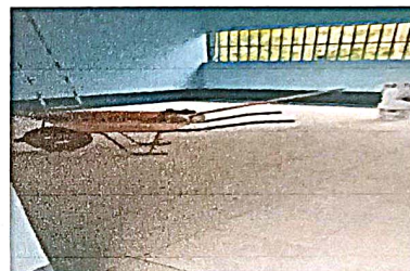
Foto 4: Sustitucion de piso ceramico
