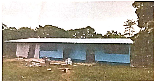
Foto1: pintura en muros exteriores e interiores
