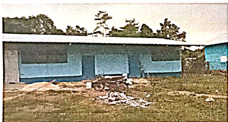
Foto 3: Sustitucion de lamina, por lamina troquelada de aluzinc calibre 26
