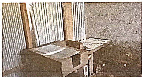
Foto 5: sustitucion de estufa rural incluye chimenea y plancha de metal
