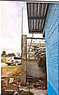
Foto 5: Instalación de acometida eléctrica
