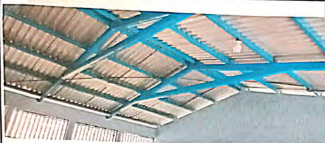
Foto 1: Sustitución de ducto eléctrico más accesorios
