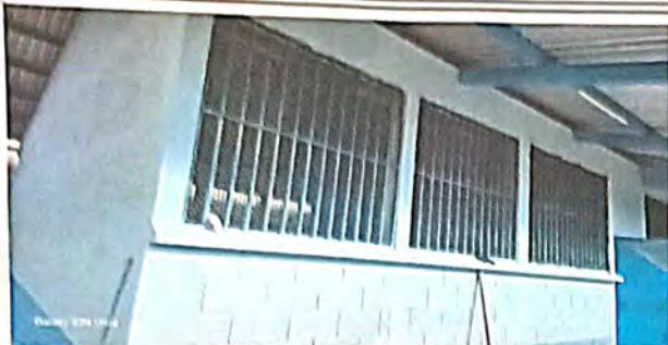
Foto 7: Pintura en muros exteriores e interiores
