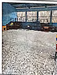
Foto 6: Sustitución de piso de torta de concreto a piso granito
