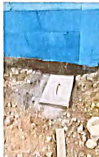
Foto 8: Sustitución de caja de registro
