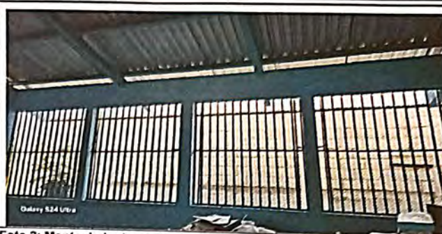
Foto 2: Mantenimiento a estructura de metal de ventana
