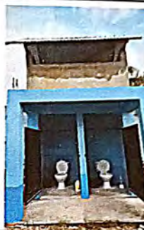
Foto 4: Sustitución de inodoro
