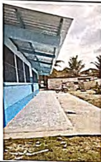
Foto 3: Reparación de planchas de concreto de patio
