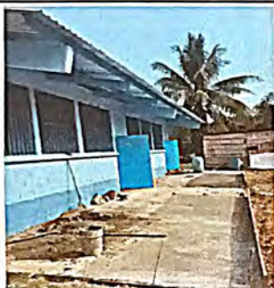
Foto 3: Reparación de planchas de concreto de patio
