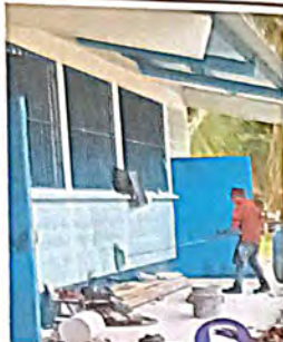
Foto 7: Pintura en muros exteriores e interiores
