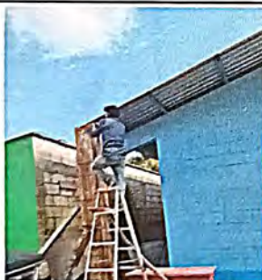
Foto 5: Instalación de acometida eléctrica
