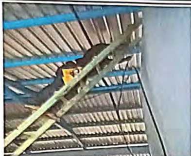
Foto 1: Sustitución de ducto eléctrico más accesorios
