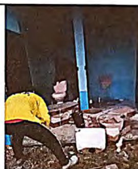
Foto 4: Sustitución de inodoro
