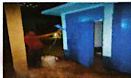
Foto 6: Mantenimiento a estructura (ajado, cambio de tubo, cepillado, sujeciones, aplicación de pintura) a puertas servicios sanitarios
