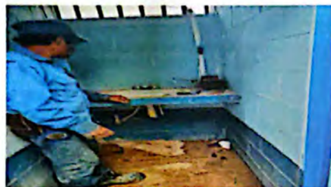
Foto 8: Sustrucción de bomba de agua
