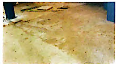
Foto 14: Sustitución de piso de torta de concreto
