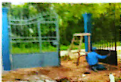
Foto 1: Sustitución de pichón de metal
