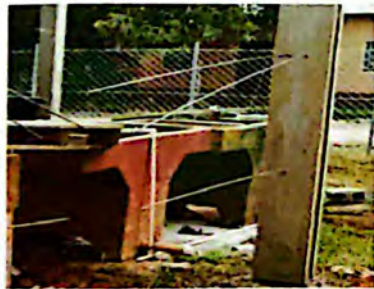
Foto 15: Sustitución de pila de cemento de dos lavadero
