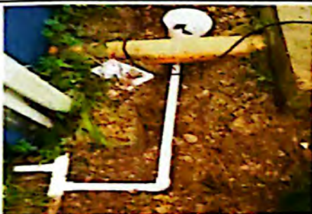
Foto 9: Sustrucción de tubería línea principal
