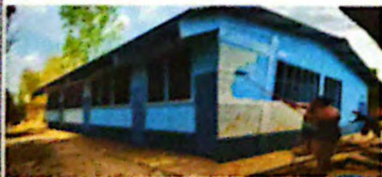
Foto 5: Pintura en muros exteriores
