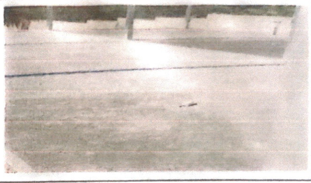
Foto 2: piso de cemento liquido
