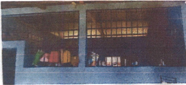
Foto 3: sustitución de balcones
