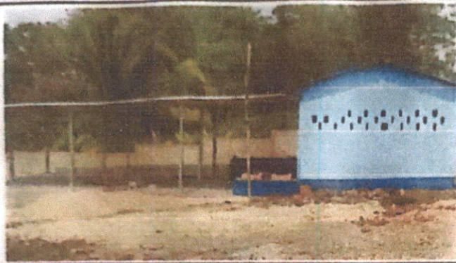
Foto 1: Cemento en muros pintura en muros interior y exterior
