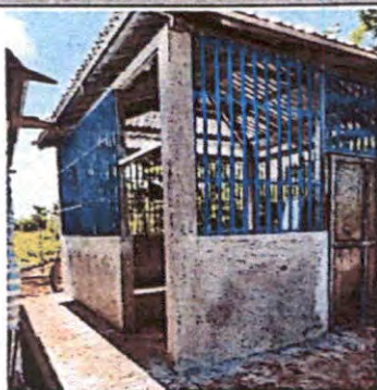
Foto 7: RENGLO 5.6 Sustitución de balcones de metal.
