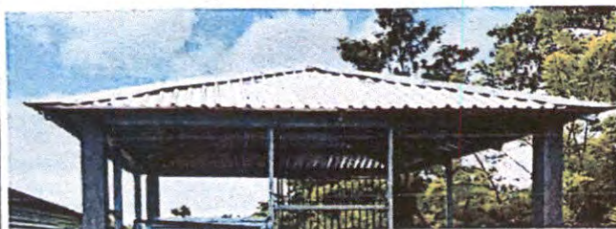
Foto 1: RENGLO 1.1 Sustitución de lámina troquelada aluzinc calibre 26
