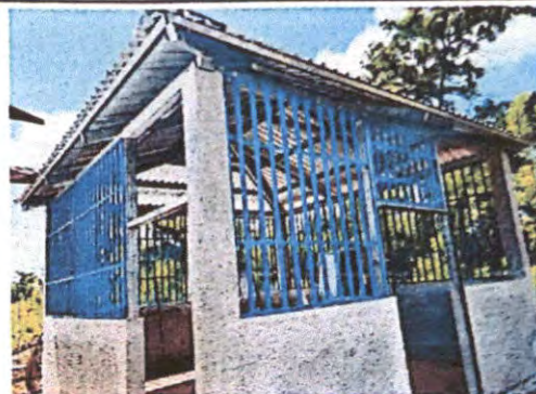
Foto 2: RENGLO 2.2 Sustitución de soporte de madera, por metal
