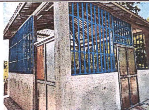
Foto 4: RENGLO 4.4 Sustitución de puertas.
