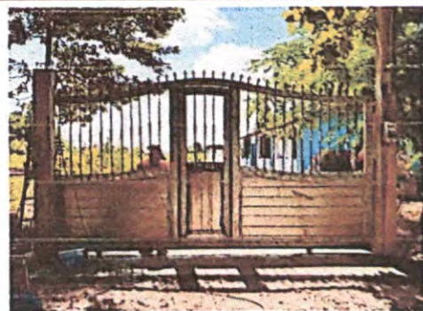
Foto 6: RENGLO 4.5 Sustitución de portón de metal.
