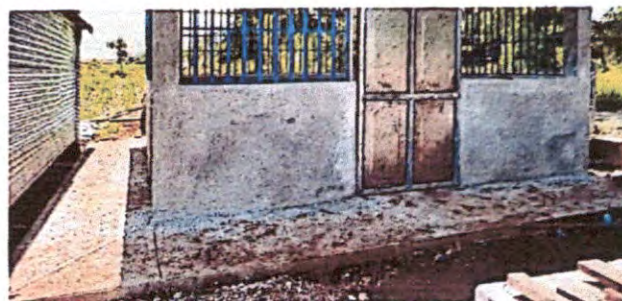
Foto 8: RENGLO 8.2 Reparación de banqueta de concreto.
