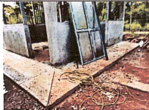
Foto 8: RENGLO 8.2 Reparación de banqueta de concreto.
