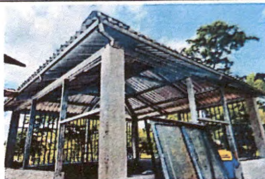
Foto 2: RENGLO 2.2 Sustitución de soporte de madera, por metal
