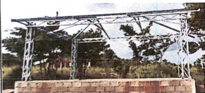
Foto 3: RENGLO 2.3 Sustitución de estructura de soporte de metal, por metal.
