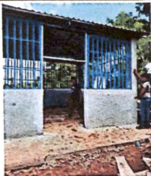
Foto 7: RENGLO 5.6 Sustitución de balcones de metal.
