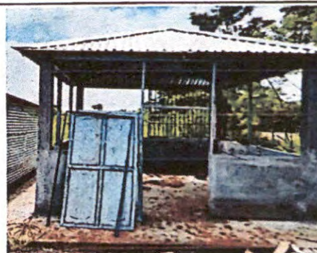
Foto 4: RENGLO 4.4 Sustitución de puertas.
