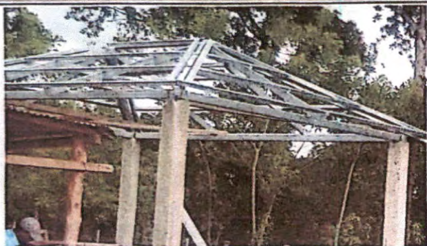
Foto 1: RENGLO 1.1 Sustitución de lámina troquelada aluzinc calibre 26
