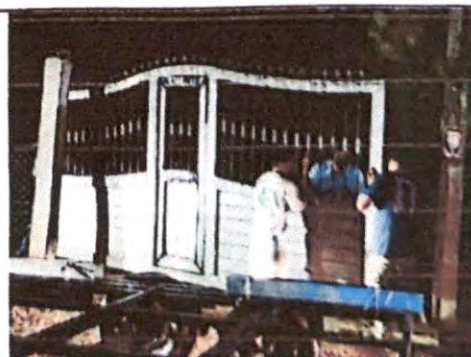
Foto 6: RENGLO 4.5 Sustitución de portón de metal.
