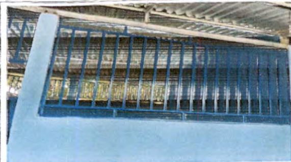
Repello en muro (ventanas)
