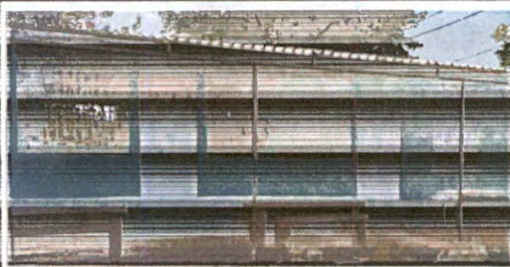
Plancha en muros exteriores
