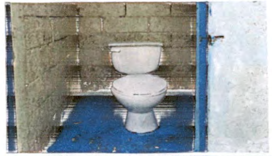
Sustitución de inodoro
