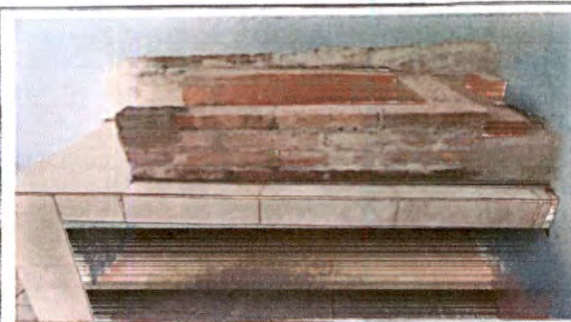
Sustitución de portavoz de metal rústico
