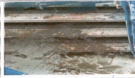
Sustitución de piso cerámico (aula)
