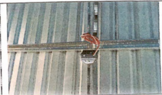
Reparación del sistema eléctrico
