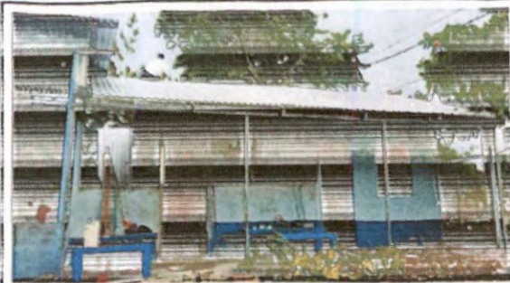
Sustitución de lámina por lámina lisa en exterior
