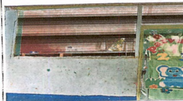
Pintura en muros exteriores
