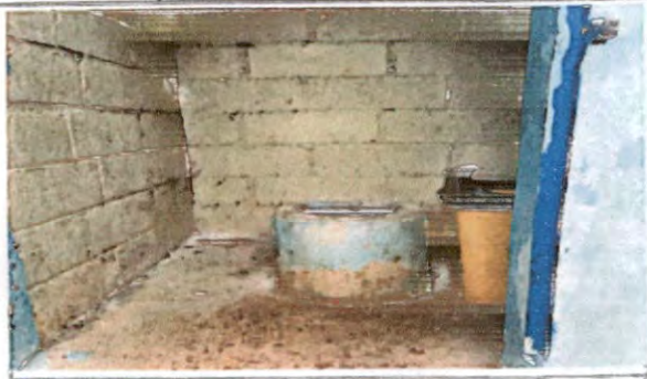
Sustitución de inodoro
