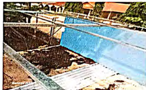
Foto 8: sustitución de estructura a estructura de soporte de metal en esenario
