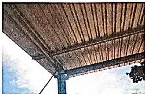
Foto 7: sustitucion de lamina por lamina troquelada aluzinc calibre 26 para esenario
