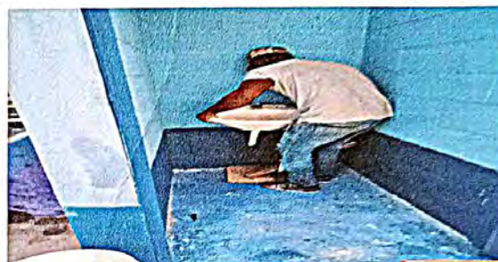
Foto 4: Sustitución de Lavamanos.
