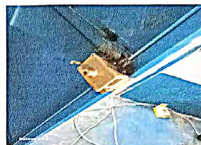
Foto 14: sustitución de chapa.
