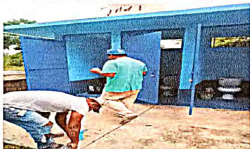
Foto 3: Mantenimiento a estructura puertas (cambio de tubo, cepillado, sujeciones y aplicación de pintura. Baños
