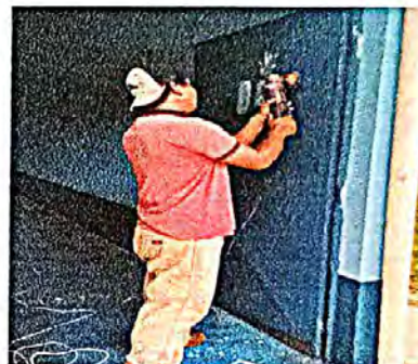
Foto 10: Mantenimiento a estructura (lijado, cambio de tubo, cepillado, sujeciones, aplicación de pintura) aulas
