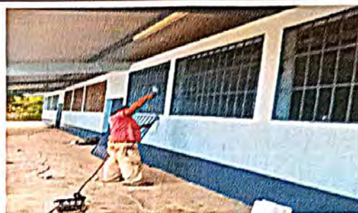
Foto 2: Sustitución de Balcones de Metal.
