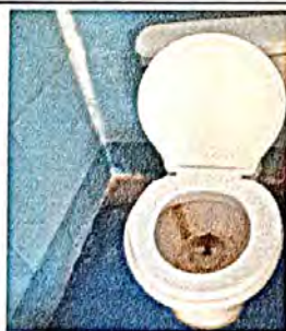
Foto 5: Sustitución de Inodoro.
