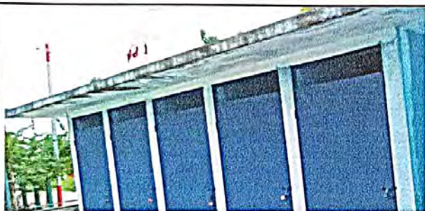
Foto 3: Mantenimiento a estructura puertas (cambio de tubo, cepillado, sujeciones y aplicación de pintura. Baños
