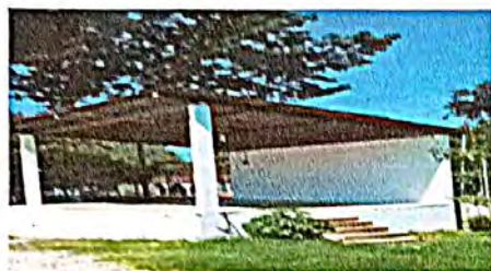
Foto7: sustitucion de lamina por lamina troquelada aluzinc calibre 26 para esenario
