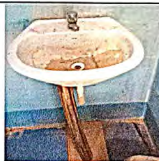
Foto 4: Sustitución de Lavamanos.
