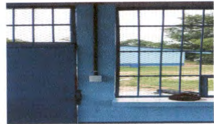
Foto 14: Sustrución de interruptor simple
