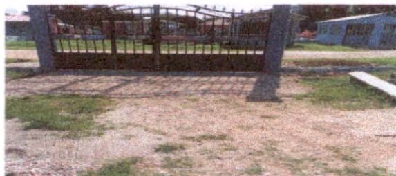
Foto 10: Sustitución de portón de metal
