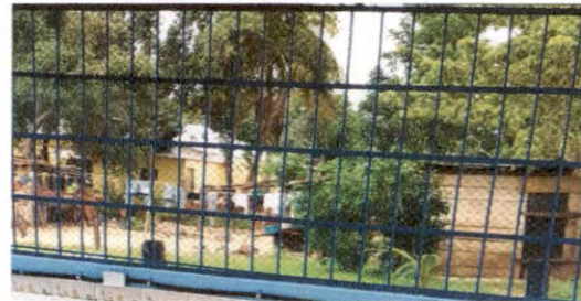
Foto 4: Sustrucción de balcones de metal
