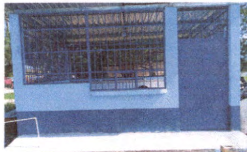
Foto 8: Repello en muro
