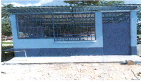
Foto1: Sustrucción de lamina, por lamina troquelada aluzinc calibre 26 0.38 mm en cocina
