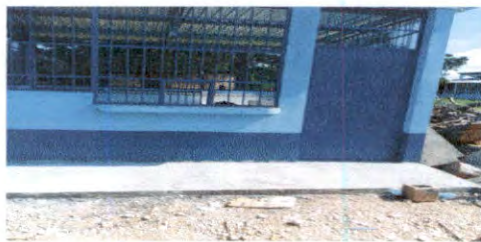
Foto 5: Sustrucción de puerta
