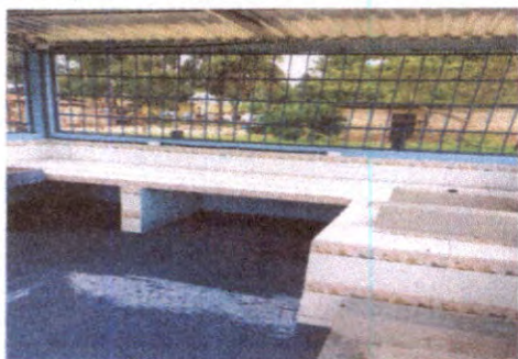
Foto 7: Instalación de azulejo en estufa rural
