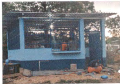
Foto 13: Sustrución de focos ahorradores
