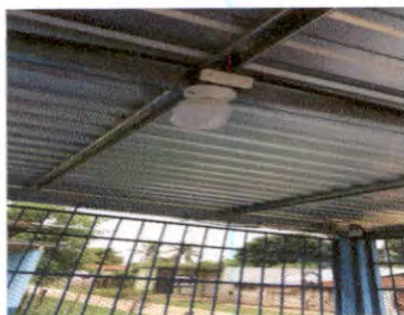
Foto 17: Reparación de cableado eléctrico
