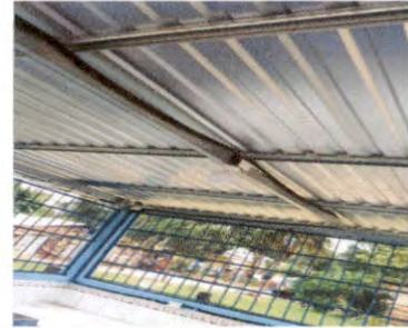
Foto 2: Sustrucción de estructura de soporte de madera por metal costanera ch 16 3x2 y Tubo Rectangular 4x2 ch16
