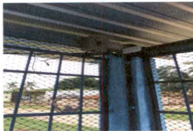
Foto 15: Sustrución de flipones
