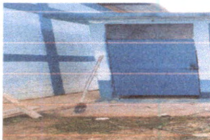
Foto 11: Mantenimiento a estructura de puerta (lijado, cambio de tubo, cepillado, sujeciones, aplicación de pintura)
