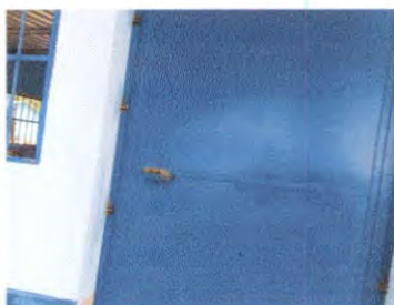
Foto 5: Sustrucción de puerta
