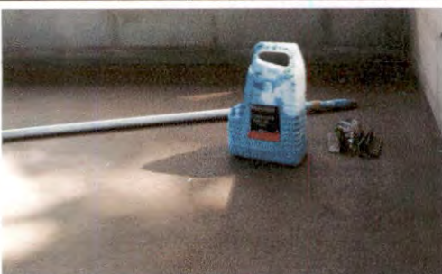
Foto 3: Sustrucción de piso de torta de concreto
