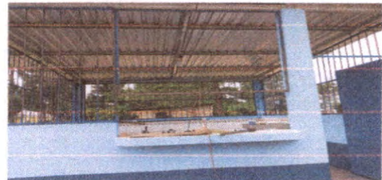
Foto 12: Pintura en muros exteriores e interiores
