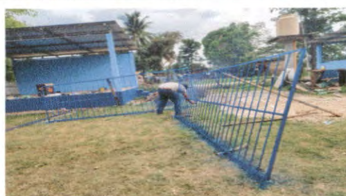
Foto 4: Sustrucción de balcones de metal
