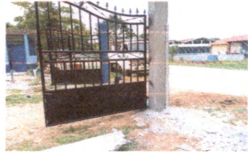
Foto 10: Sustitución de portón de metal
