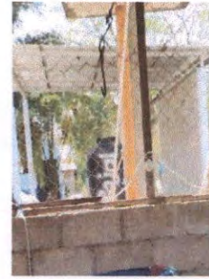
Foto 14: Sustrucción de interruptor simple
