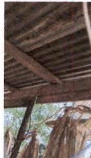
Foto 17: Reparación de cableado eléctrico
