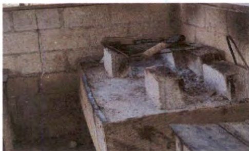
Foto 7: Instalación de azulejo en estufa rural
