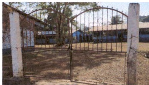
Foto 10: Sustitución de portón de metal
