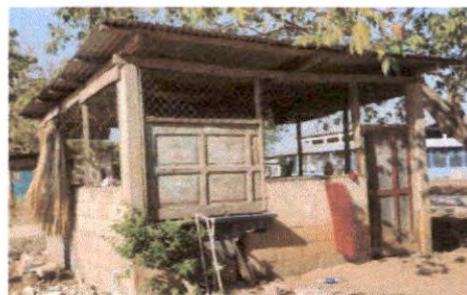
Foto 12: Pintura en muros exteriores e interiores
