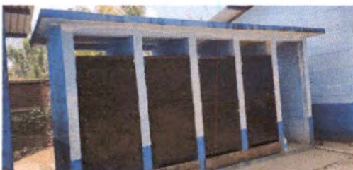
Foto 11: Mantenimiento a estructura de puerta (lijado, cambio de tubo, cepillado, sujeciones, aplicación de pintura)
