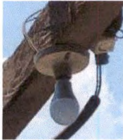
Foto 13: Sustrucción de focos ahorradores
