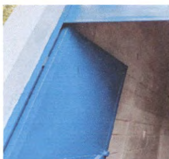
Foto 8: Mantenimiento a estructura de puertas de metal
