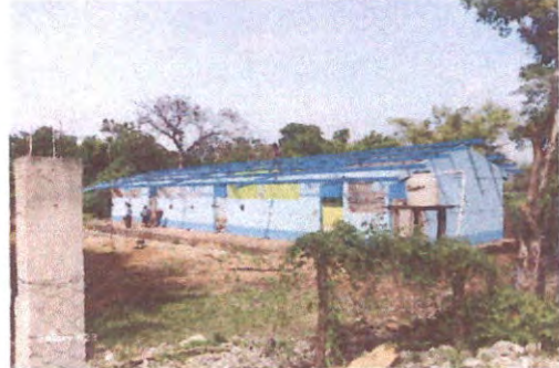
Foto 2: Mantenimiento a estructura de soporte de metal
