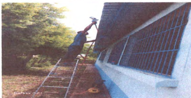
Foto 5: Sustitución de balcones de metal
