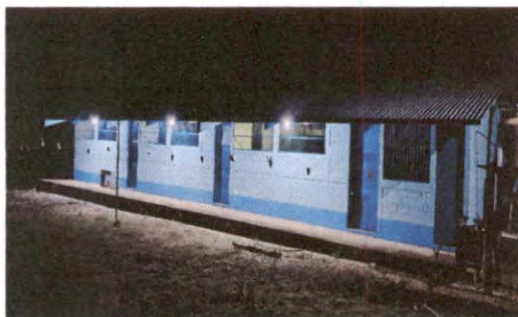
Foto 11: Sustitución de focos ahorradores
