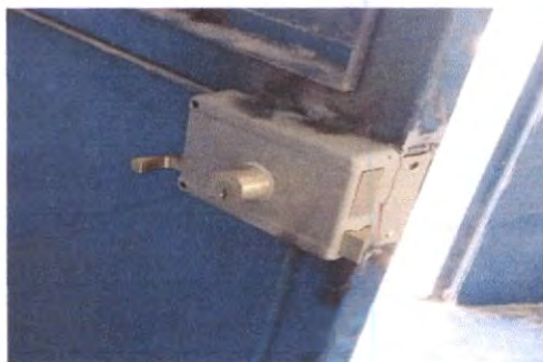
Foto 7: Sustitución de chapa
