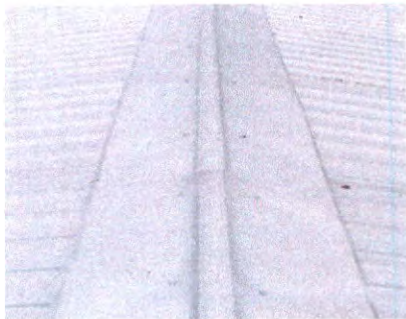
Foto 3: Sustitución de capote de lámina para lámina troquelada
