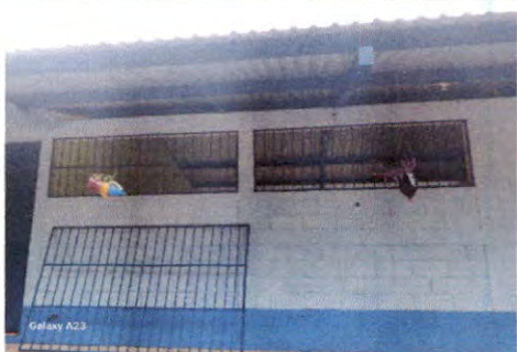
Foto 5:Sustitución de balcones de metal
