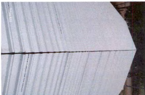
Foto1: Sustitución de lamina, por lamina troquelada aluzinc calibre 26 modulo de aulas
