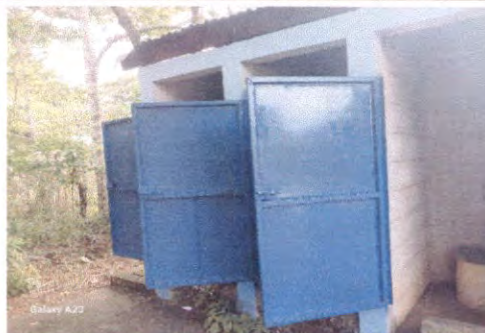
Foto 6: Mantenimiento a estructura (lijado, cambio de tubo , cepillado, sujeciones, aplicación de pintura) a puertas servicios sanitarios
