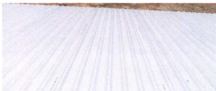
Foto 4: Sustitución de elementos de fijacion
