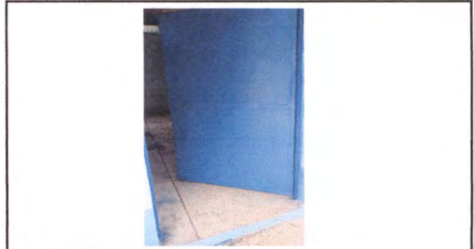
Foto 8: Mantenimiento a estructura de puertas de metal
