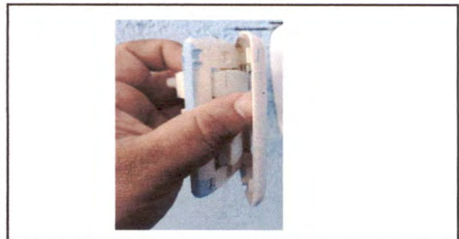
Foto 12: Sustitución interruptores simples
