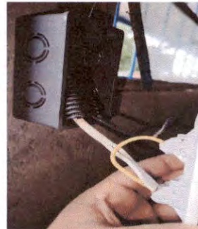
Foto 14:Sustituciónde tomacorrientes dobles
