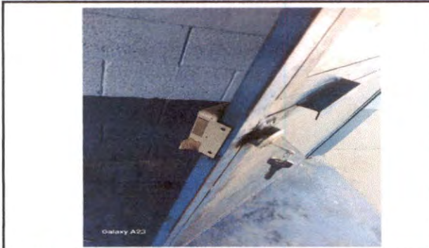
Foto 7: Sustitución de chapa
