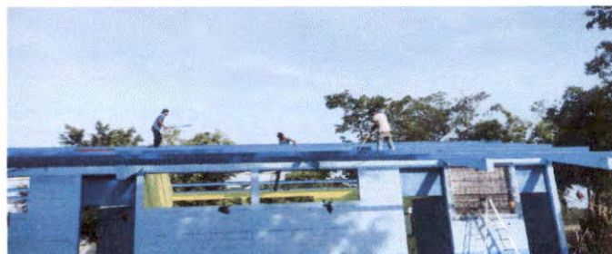
Foto 2: Mantenimiento a estructura de soporte de metal
