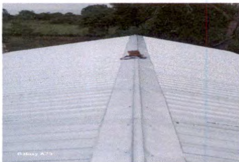
Foto 3:Sustitución de capote de lámina para lámina troquelada
