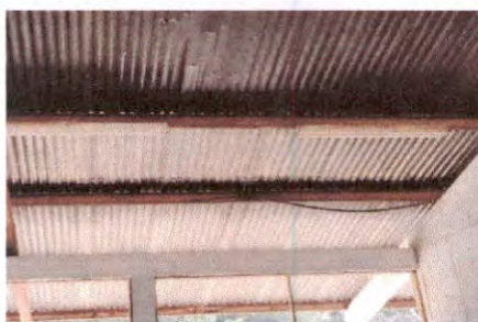
Foto 9: Reparación de cableado eléctrico
