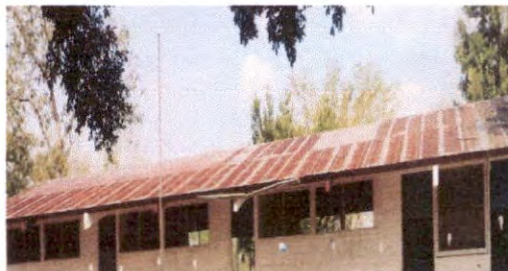
Foto 4: Sustitución de elementos de fijacion
