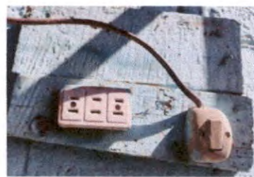
Foto 14: Sustrucción de tomacorrientes dobles
