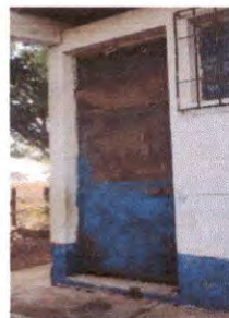
Foto 8: Mantenimiento a estructura de puertas de metal
