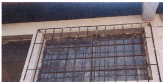
Foto 5: Sustitución de balcones de metal
