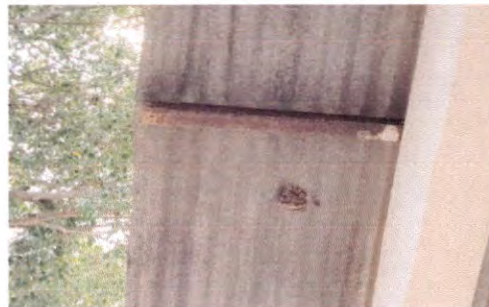
Foto 2: Mantenimiento a estructura de soporte de metal
