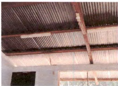
Foto 13: Sustrucción de plafoneras
