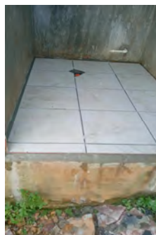
4. SUSTITUCIÓN DE INODORO
