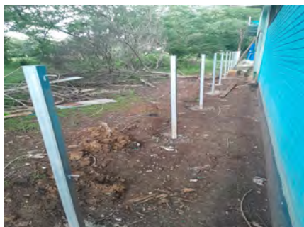
3. REPARACION DE TUBO HG Y MALLA GALVANIZADA
