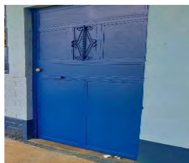
6. SUSTITUCIÓN DE CHAPA
