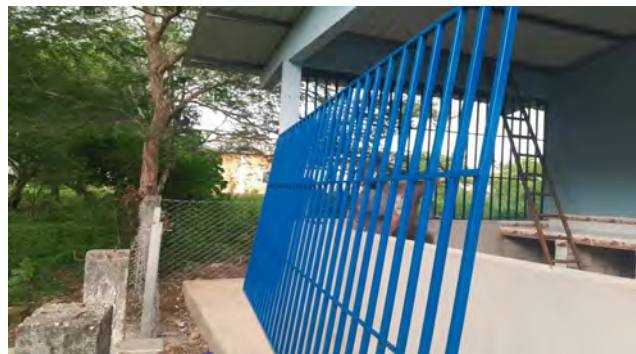
2. SUSTITUCIÓN DE BALCONES
