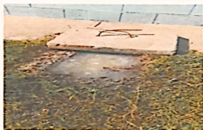
Reparación del sistema de drenaje
