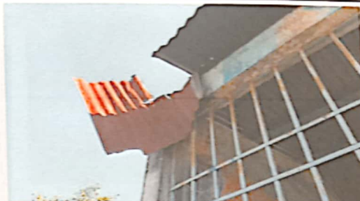
Sustitución de techo
