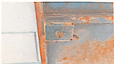
Sustitución de chapas de puertas
