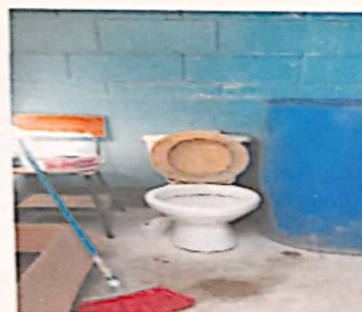
Sustitución de tazas de baño
