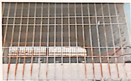
Mantenimiento a balcones de metal
