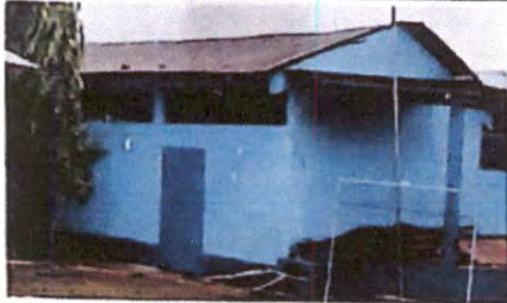
SUSTITUCIÓN DE PUERTA
