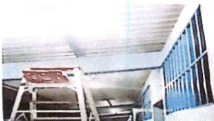
SUSTITUCIÓN DE PLAFONERA
