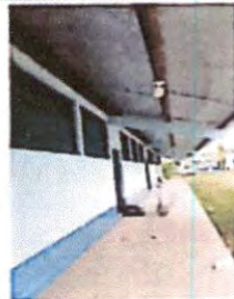
MANTENIMIENTO EN BALCON DE METAL
