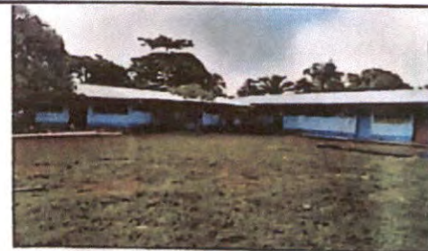
PINTURA EN EXTERIORES
