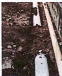
SUSTITUCIÓN DE TUBERÍA PVC LÍNEA PRINCIPAL DE AGUAS NEGRAS
