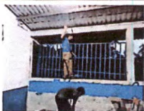
MANTENIMIENTO EN BALCON DE METAL
