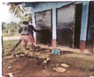
SUSTITUCIÓN DE PUERTAS EN SERVICIO SANITARIO
